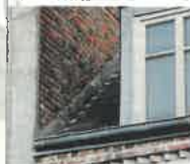
Gouttières havraises sur corniche.
