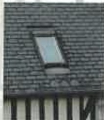
Châssis intégré dans le plan de la couverture.
